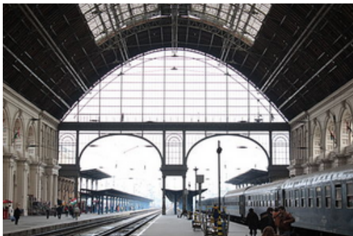
Sezione trasversale del tetto della stazione ferroviaria Keleti (Budapest) forma una catenaria
